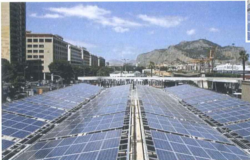
L'INTERVENTO RIENTRA NEL PROGETTO SICHEO, AVVIATO NEL 2012, AVENTE COME OBIETTIVO LA RIQUALIFICAZIONE GREEN DELL'INTERA ZONA PORTUALE DI PALERMO
