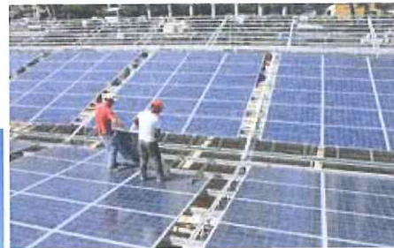
I LAVORI PER L'INSTALLAZIONE DEI MODULI FOTOVOLTAICI SULLE PENSILINE, CHE SONO STATE PREDISPOSTE PER OSPITARE STAZIONI DI RICARICA DI VEICOLI ELETTRICI, SI SONO PROTRATTI PER CIRCA DUE MESI
