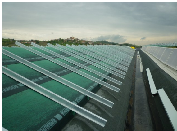
Posizionamento profili fissaggio moduli
